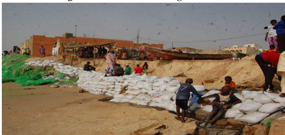
Image : construction d'une digue de fortune
