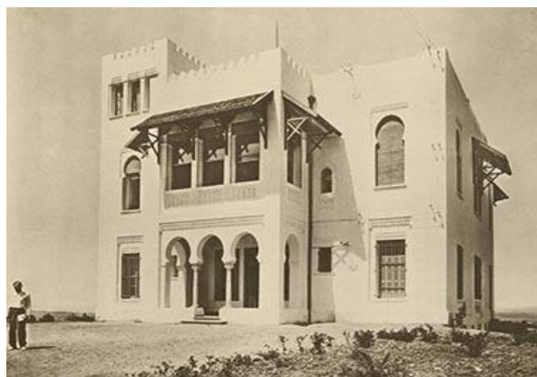
fig. 4 : Loggia fermée en panneaux vitrés par les volets roulants
