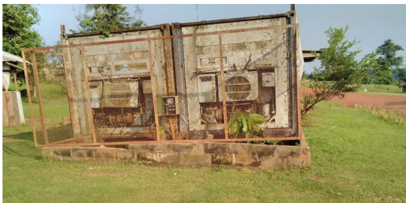
Photo 11: Ancienne chambre froide de la CIB abandonnée depuis les années 2008 Prise de vues : G.R. MOUANDA NIAMBA, juin 2022
