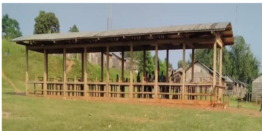
Photo 12 : Marché de Kabo construit par la CIB et actuellement presque abandonné Prise de vues : G.R. MOUANDA NIAMBA, juin 2022
