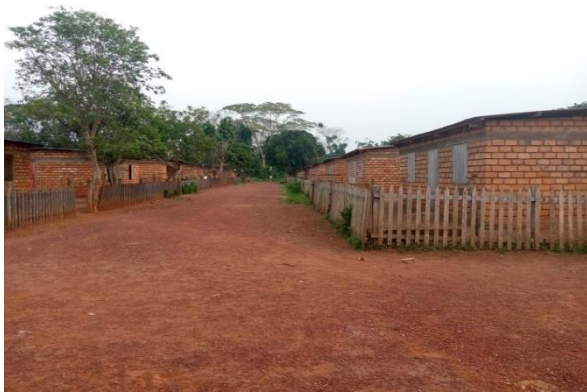
Photo 6 : Habitations construites par la société Bois-Sangha Prise de vues. G.R MOUANDA NIAMBA, mai 2022
