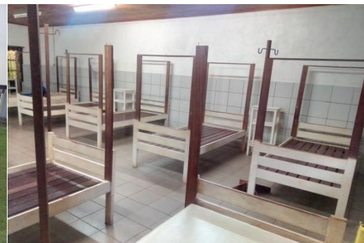
Photo 2. Infirmerie de Kabo construite par la CIB, vue de l'intérieur Prise de vues. G.R. MOUANDA NIAMBA, juin 2022
