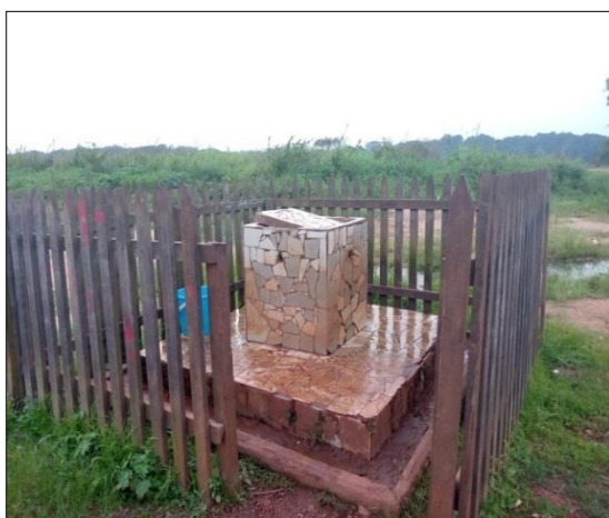
Photo 4. Fontaine alimentant les ménages en eau potable Prise de vues. G.R. MOUANDA NIAMBA, juin 2022
