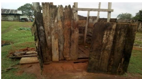
Photo n°9 : Vue de WC et douche au bord de la rue dans la ville d'Enyelle (Cliché de Lais LIBOBOU, 2021)
