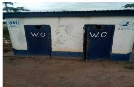
Photo n°10: Vue des WC construits par AARREC, à Bétou (Cliché : Lais LIBOBOU, 2021)
