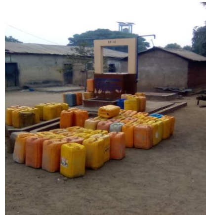
Photo 2b : Pompe autonome à Ouèssè
