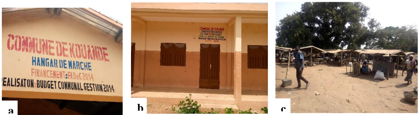
Planche 1: Quelques infrastructures marchandes réalisées dans le marché de Kouandé centre
